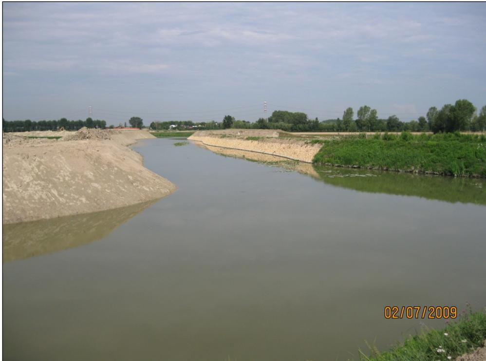
RISEZIONAMENTO DEL PIONCA A VALLE DEL TAGLIO DI MIRANO
