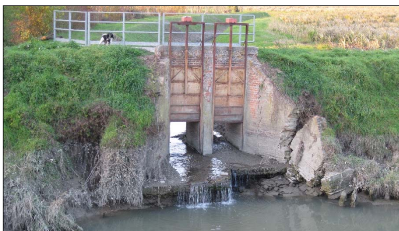
Figura 34. Manufatto di scarico della Fossa Donne in Lusore
