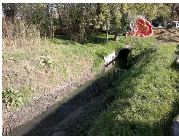
Figura 69. Tratto iniziale del fosso "Reale"
