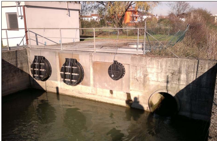
Figura 65. Sfioratore di piena sullo scolo Soresina
