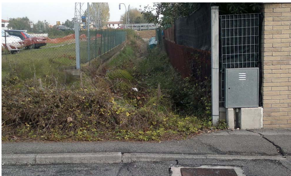
Figura 23. affossatura lato est parcheggio (linea "5")
