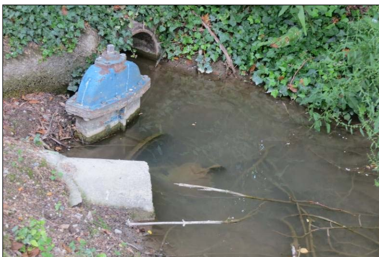
Figura 92. Punto di uscita di un tombinamento
