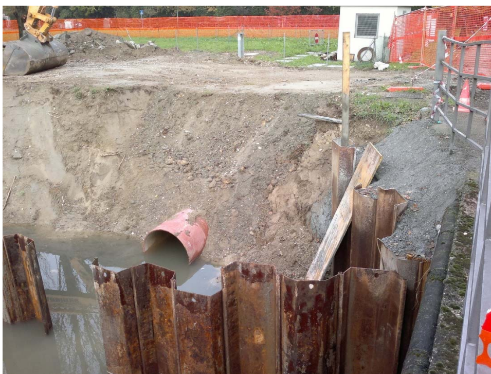
Figura 20. Lavori attualmente in corso presso l'impianto di via Romagna
