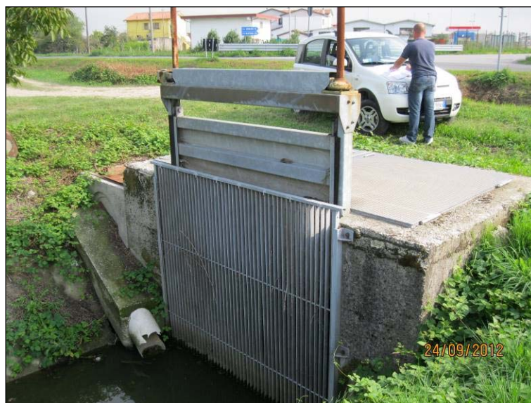
Figura 73. Imbocco del sifone posto in corrispondenza dell'inizio dello scolo Dogaletto
