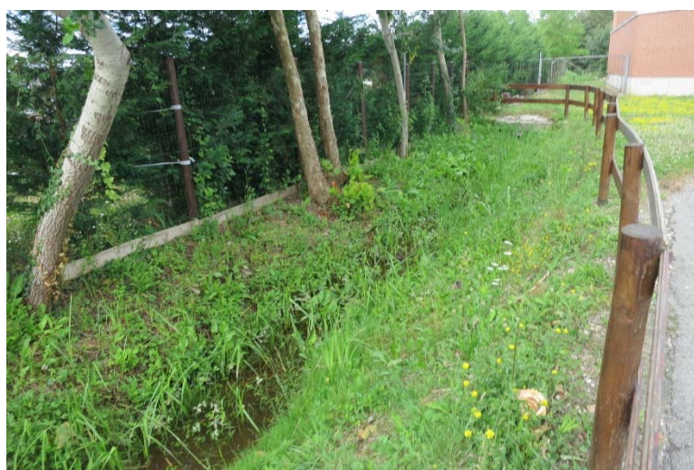
Figura 42. Stato di manutenzione esistente
