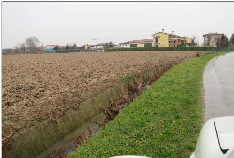
Figura 96. Manufatto in CLS presente a Est della ferrovia - presenza di deposito sul fondo
